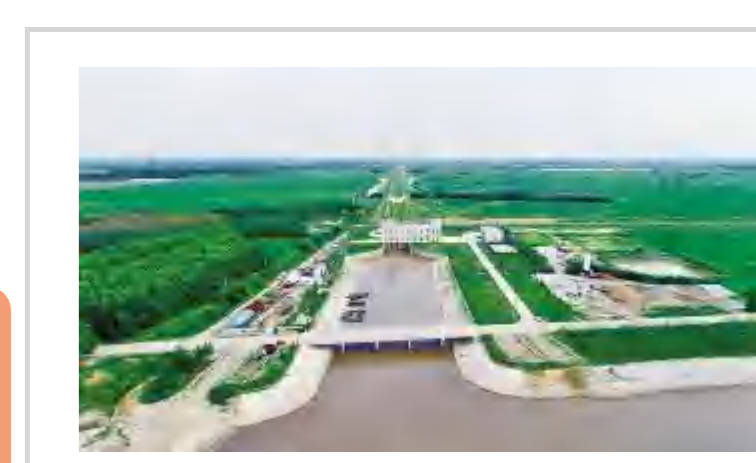
水利水电集团三村灌区项目
