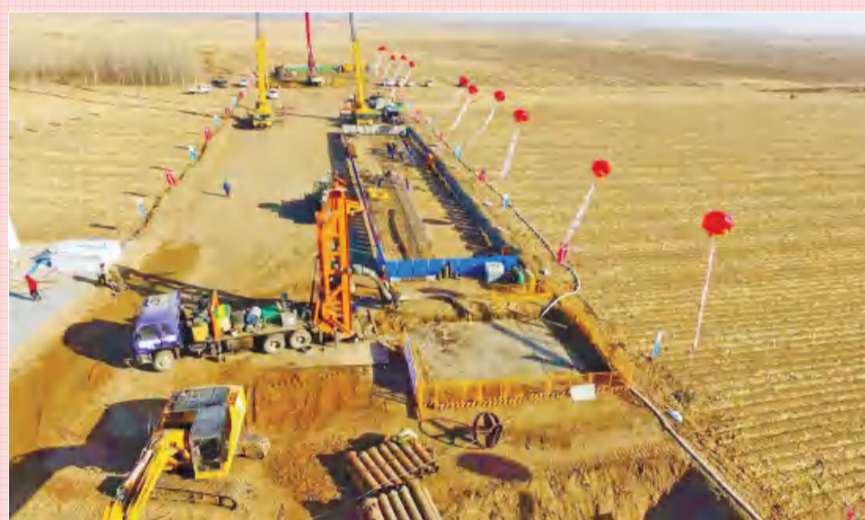
黑龙江省首个高速公路PPP项目—鹤大高速公路佳木斯过境松花江特大桥正式试桩
