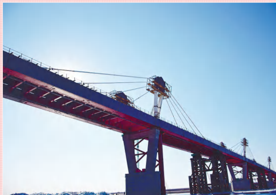
黑龙江大桥主桥钢梁顶推施工完美收官
